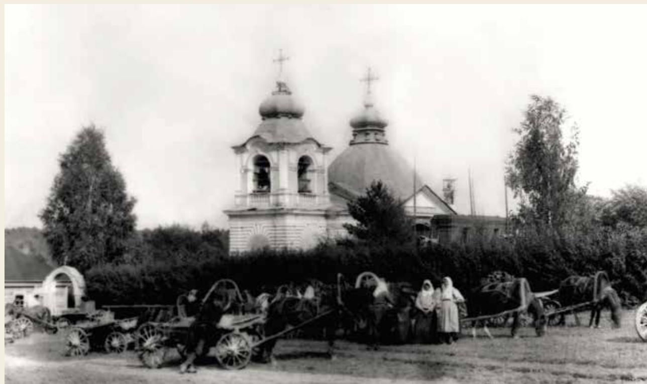
Начало реконструкции южного придела, 1908 г. Академия архитектуры СССР. Фототека Музея архитектуры. Начало XX в.
